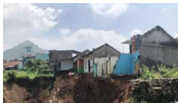
Gambar 6. Kondisi bangunan Pasca Longsor di daerah Cimanggung (Sulastri, 2021).
